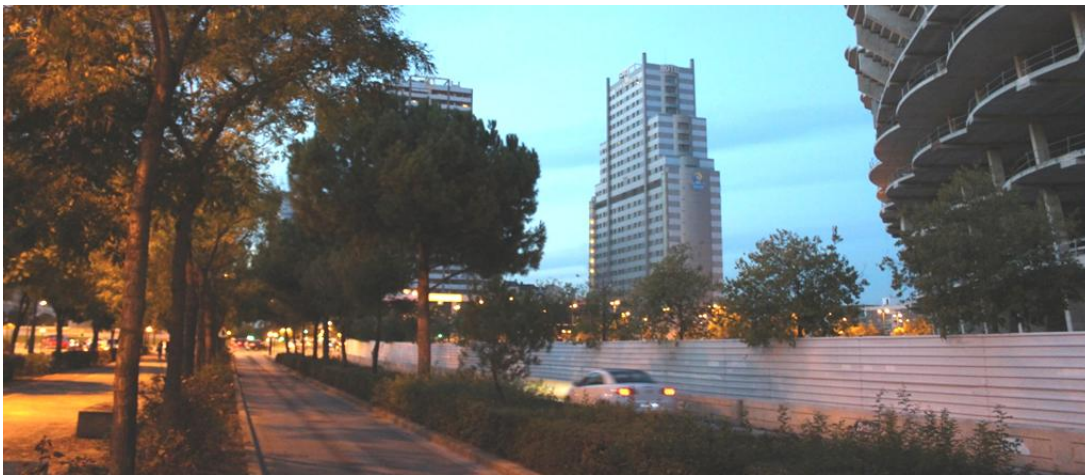
Imagen. Carril bus y vía lateral actual en la Avda. de las Cortes Valencianas
